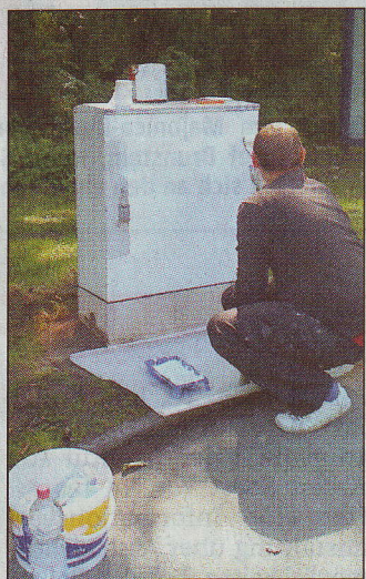
SEN-Mitarbeiter säubern die Stromkästen im Soester Süden und grundieren sie weiß.
